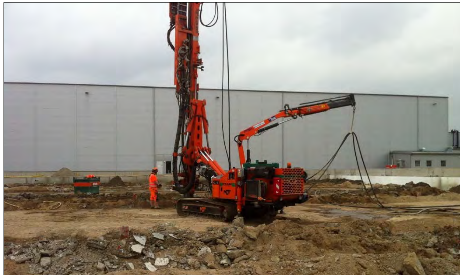
Figur 11. Tillverkning av testpelare i fält.
